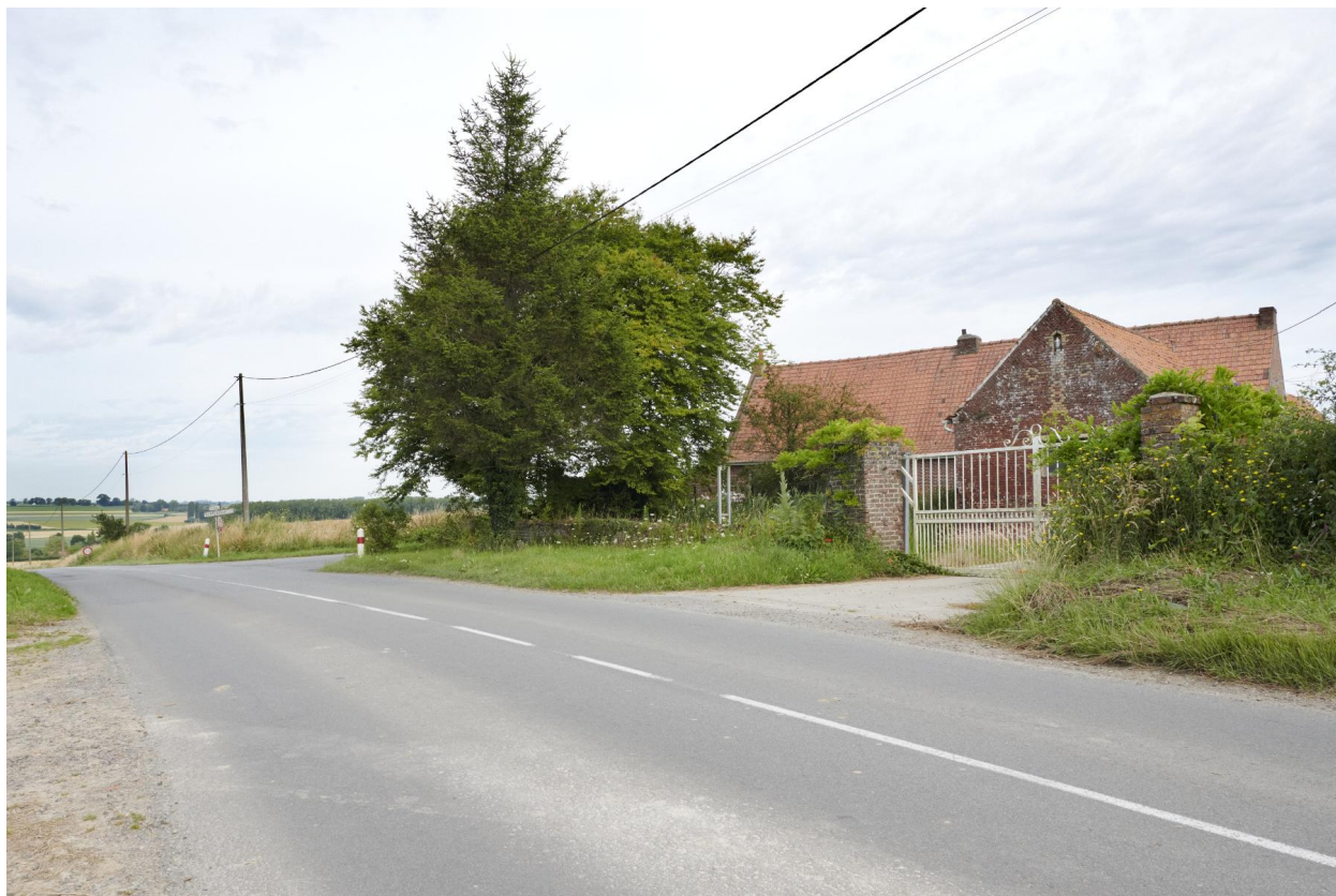
Vue générale depuis la route, au sud.
