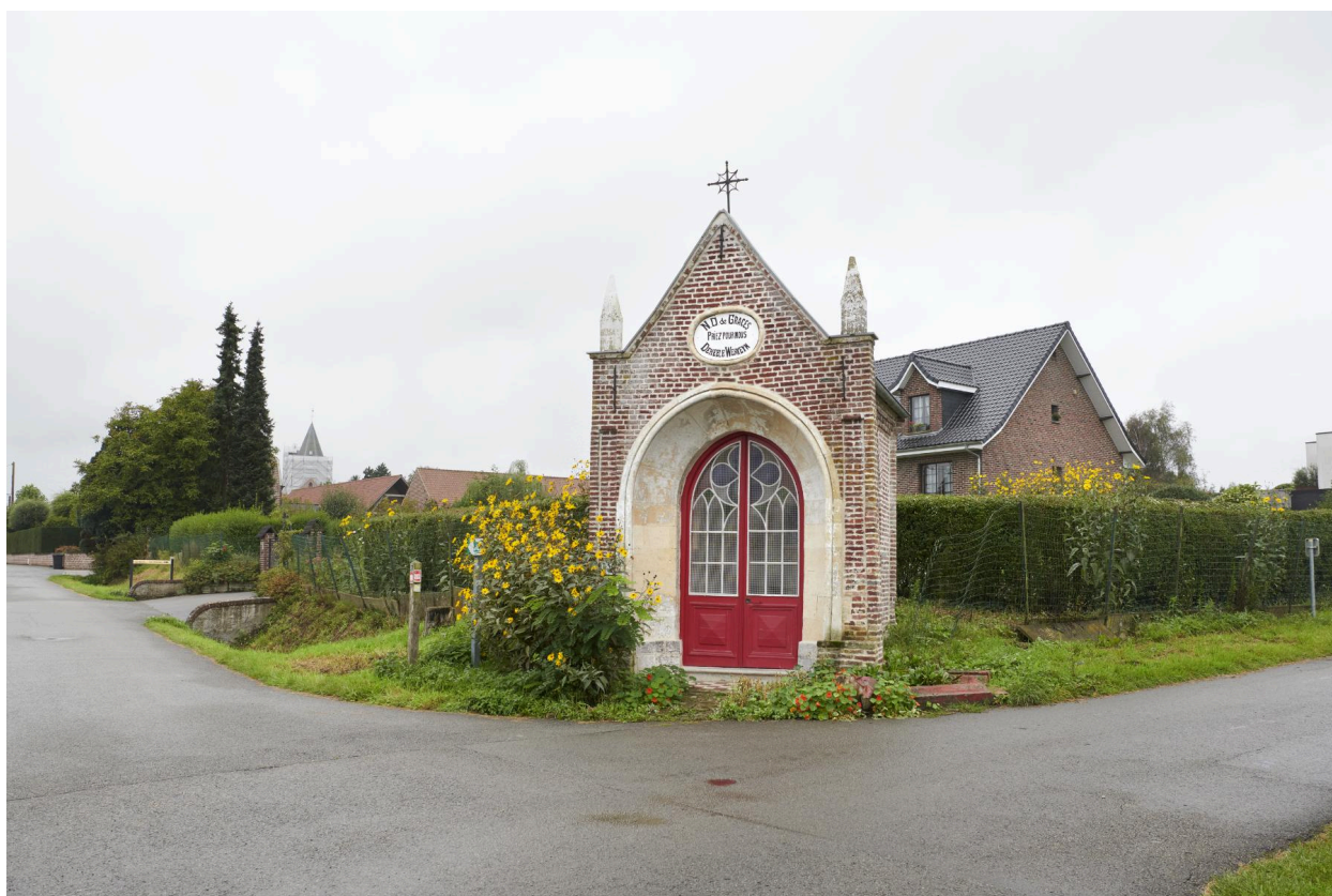
Chapelle dans son environnement de proximité.
