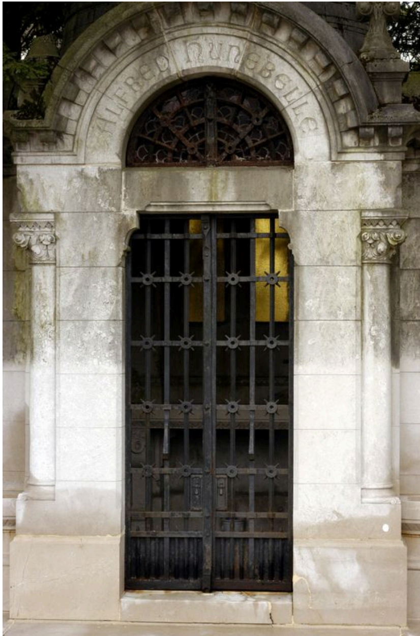
Vue de détail sur la porte.
