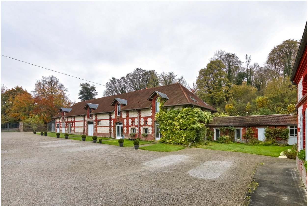
Vue du bâtiment agricole nord, depuis l'est.
