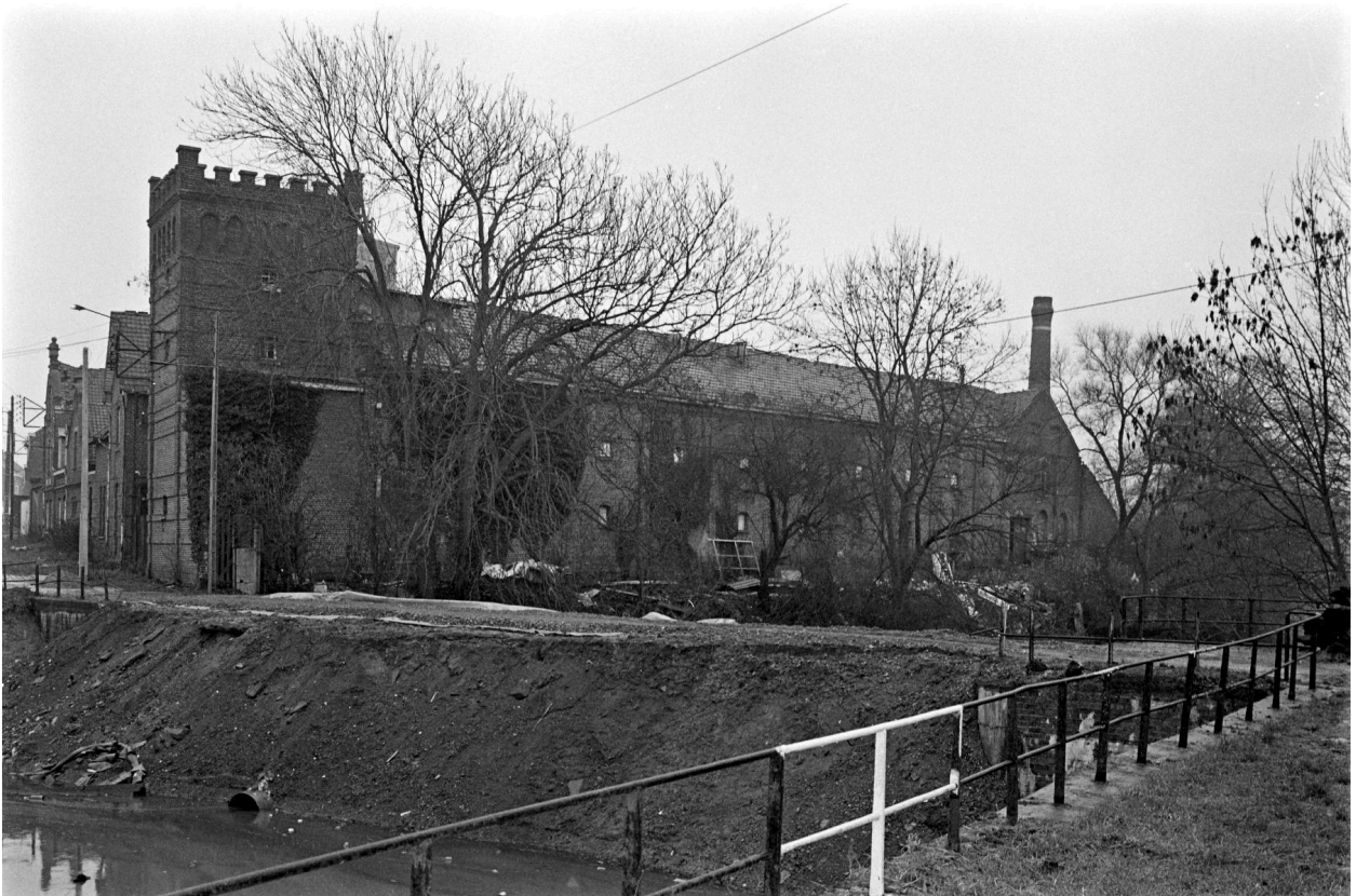
Vue générale prise vers le sud.
