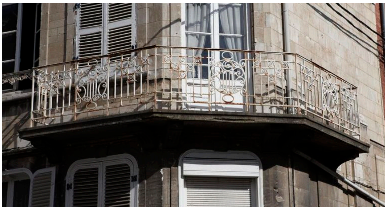
Ferronnerie Art déco du balcon situé à l'angle.
