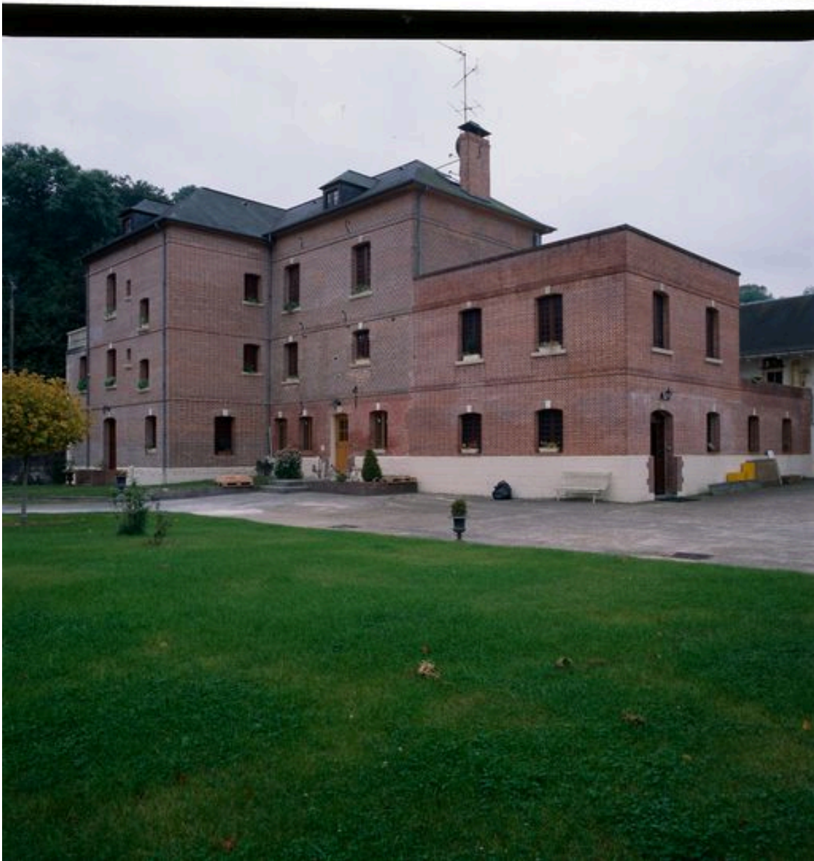
Vue d'ensemble nord-est du moulin.
