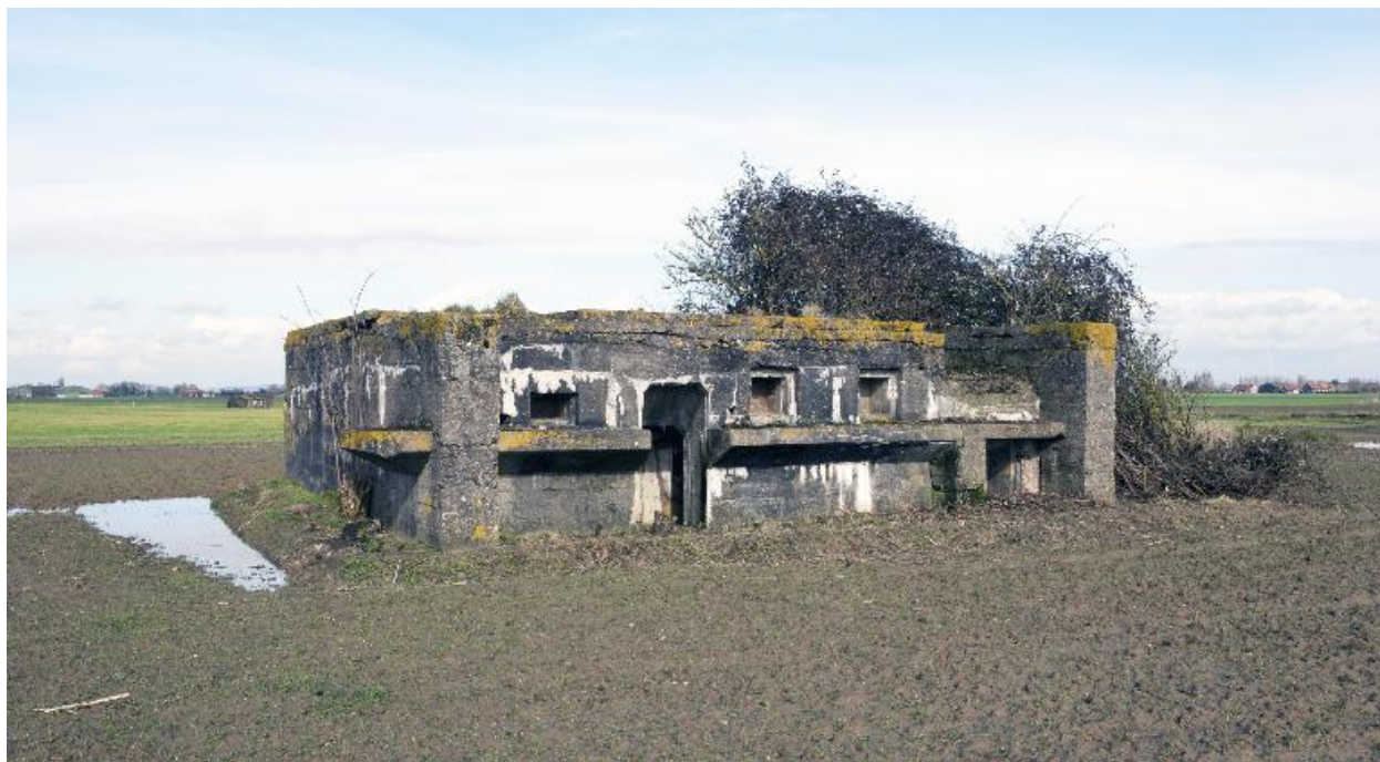
Vue de trois-quarts vers le nord
