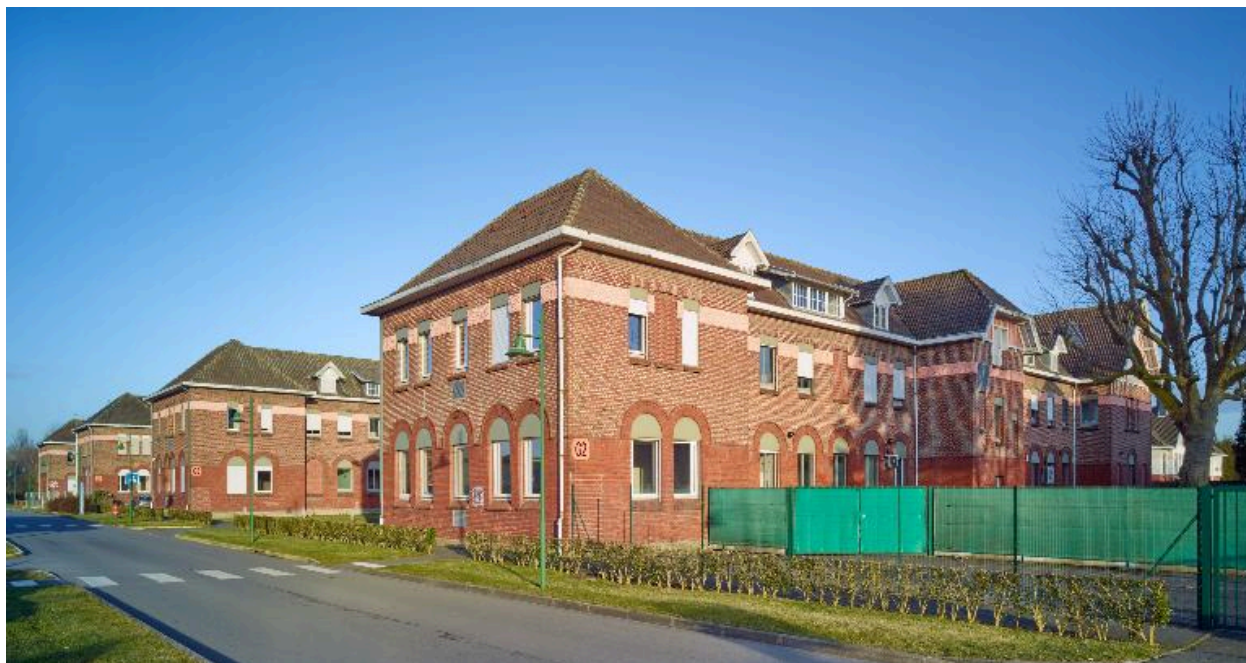
Alignement des bâtiments d'hospitalisation dit pavillons G2, G3, G4 et G5, vue de l'ensemble de ces pavillons prise en enfilade sur leur flanc gauche.
