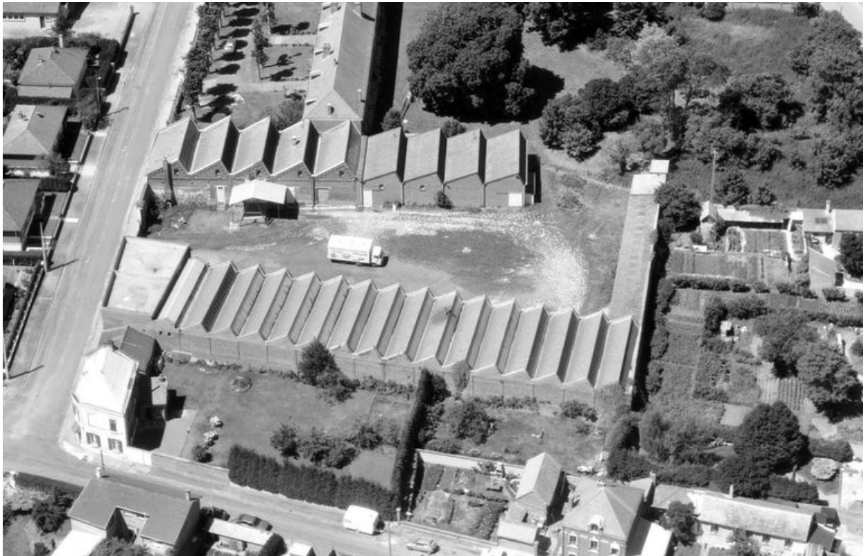
Vue aérienne, flanc est.
