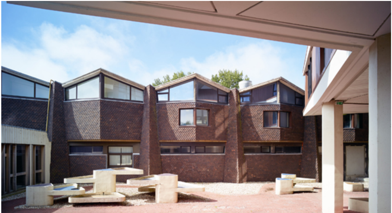
Vue de l'élévation sud des cuisines pédagogiques et de deux ensembles de sculptures-fontaines du groupe de l'Œuf, dans l'ancien patio d'accueil.
