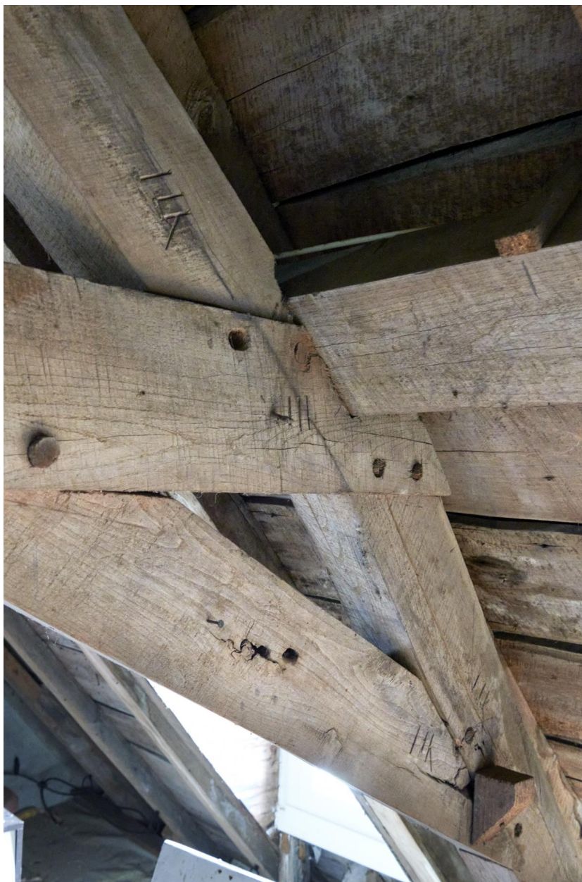
Détail de la charpente de l'ancien presbytère.
