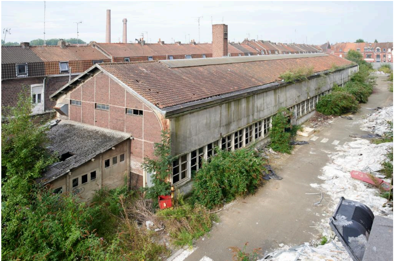
Magasin sud vu en plongée depuis le premier étage de la filature, vers l'ouest.
