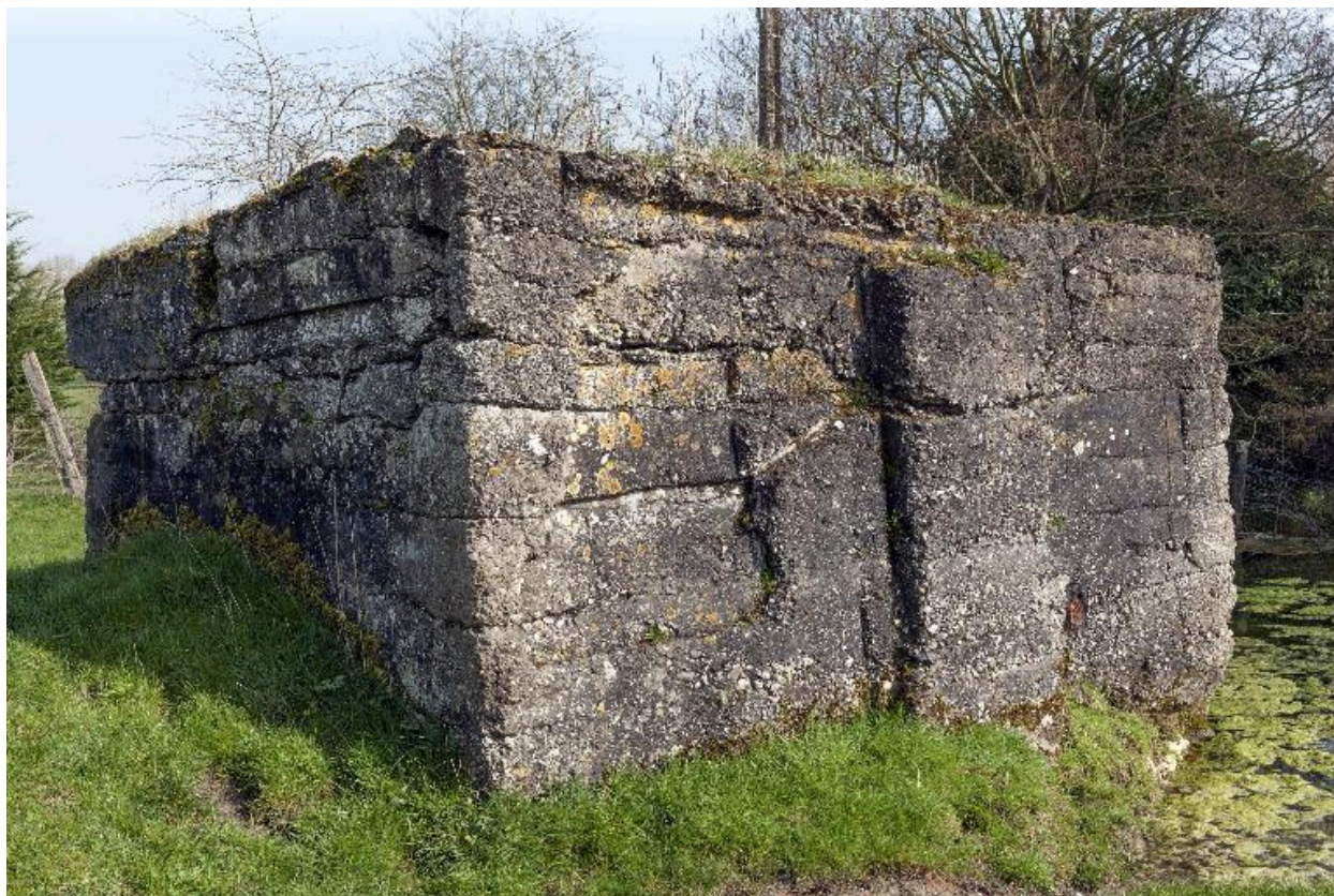
Vue de trois-quarts vers le sud-est
