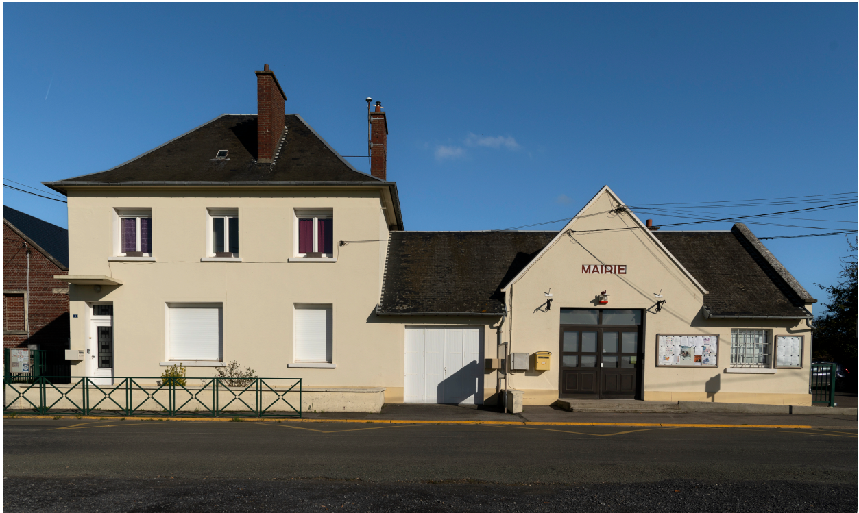
Logement de l'instituteur et mairie, années 1950, n°3 de la rue Yves-Maréchal, vue depuis l'ouest.
