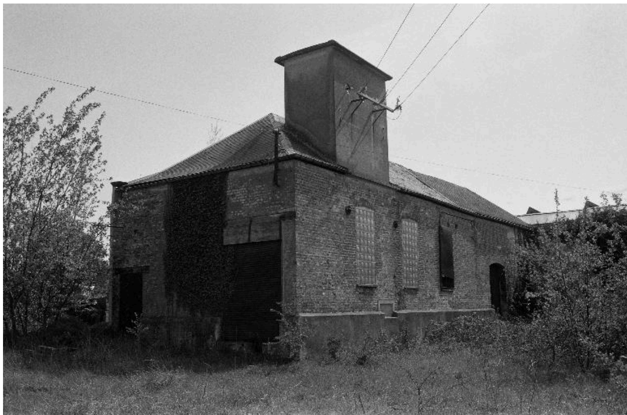
Chaufferie (?) et transformateur.
