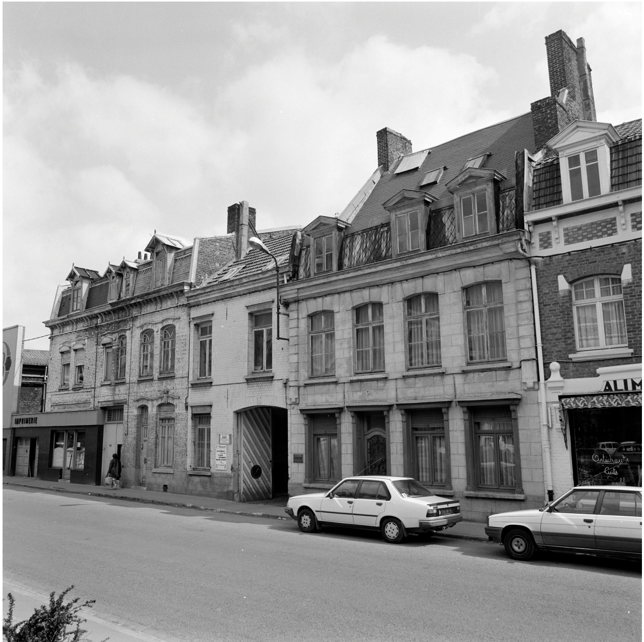
Vue générale depuis la rue des Fusillés (cf. angle de prise de vue 1).
