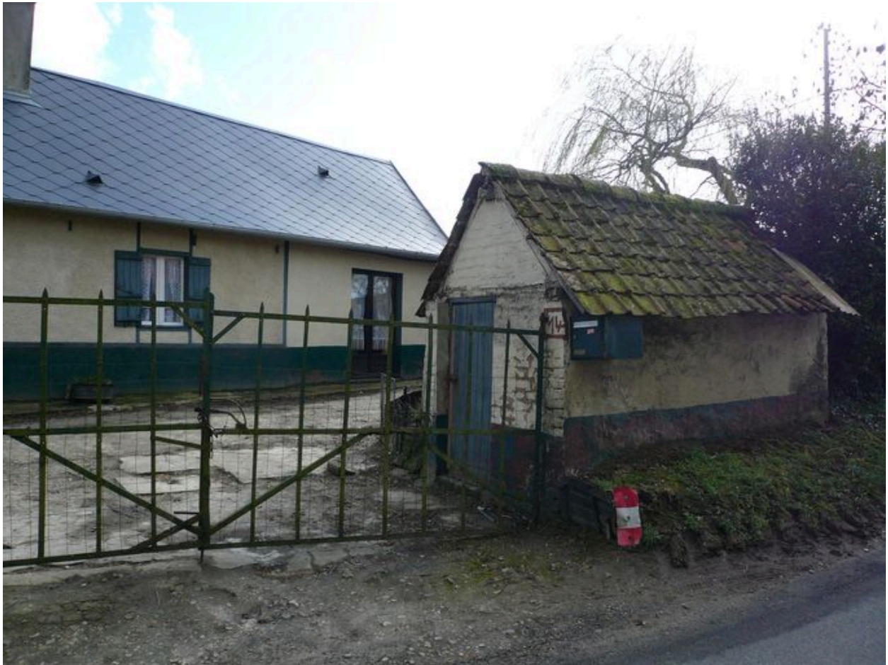
Vue d'une des deux dépendances.
