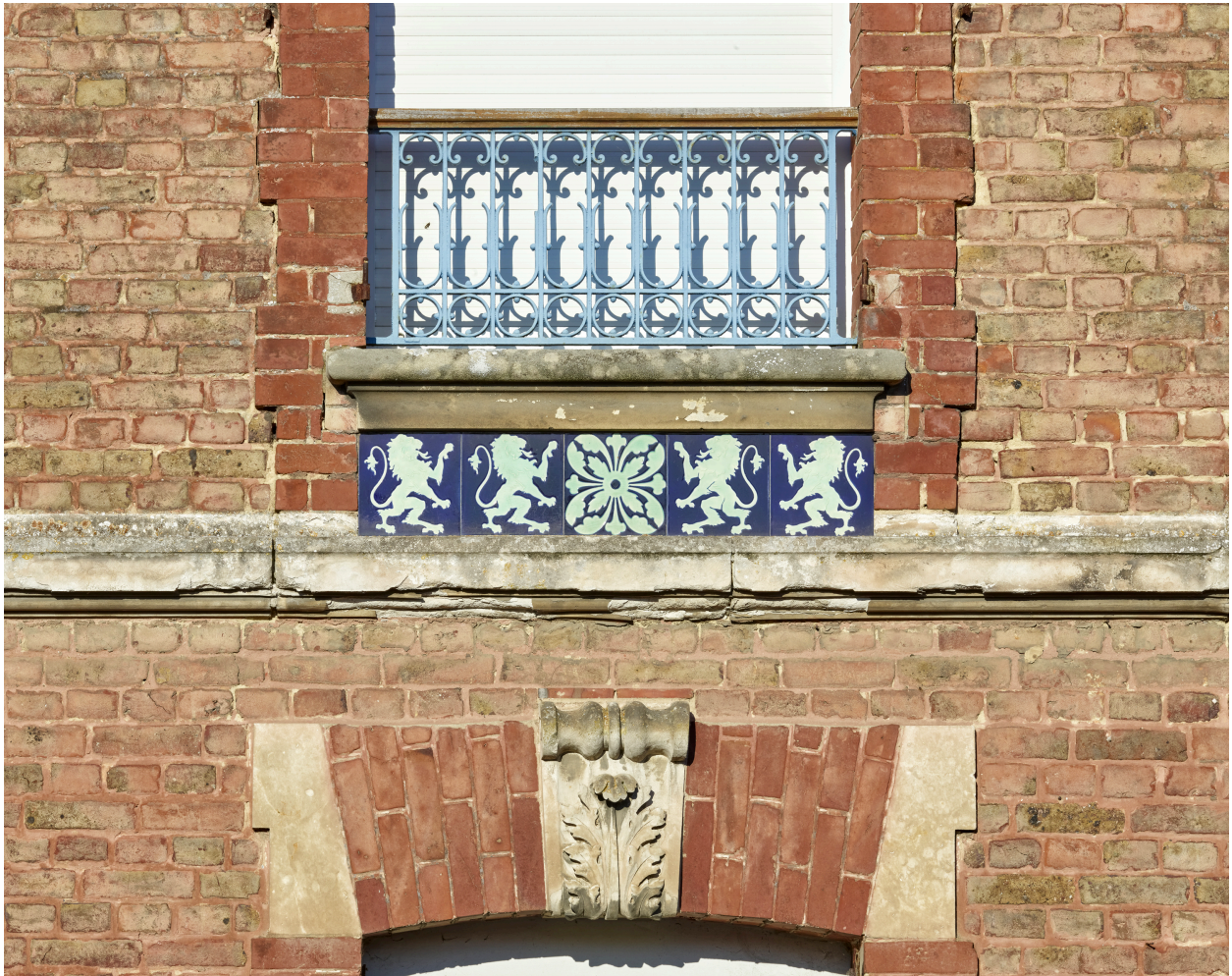
Détail des céramiques sous l'assise de la fenêtre centrale du premier étage.
