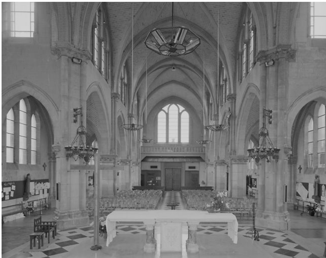
Vue intérieure vers l'est.
