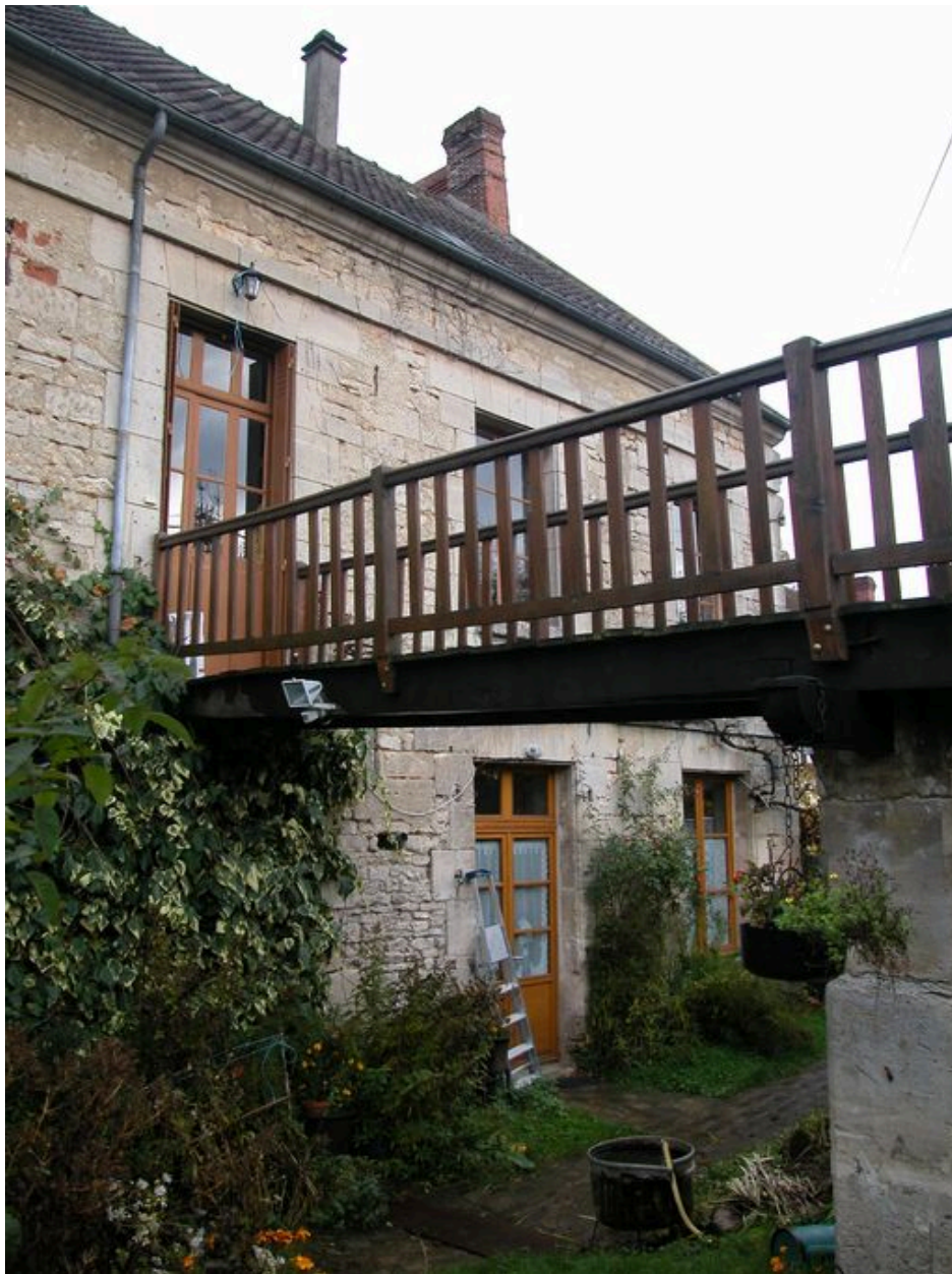
Vue du pont reliant le premier étage de la filature au chemin d'accès.
