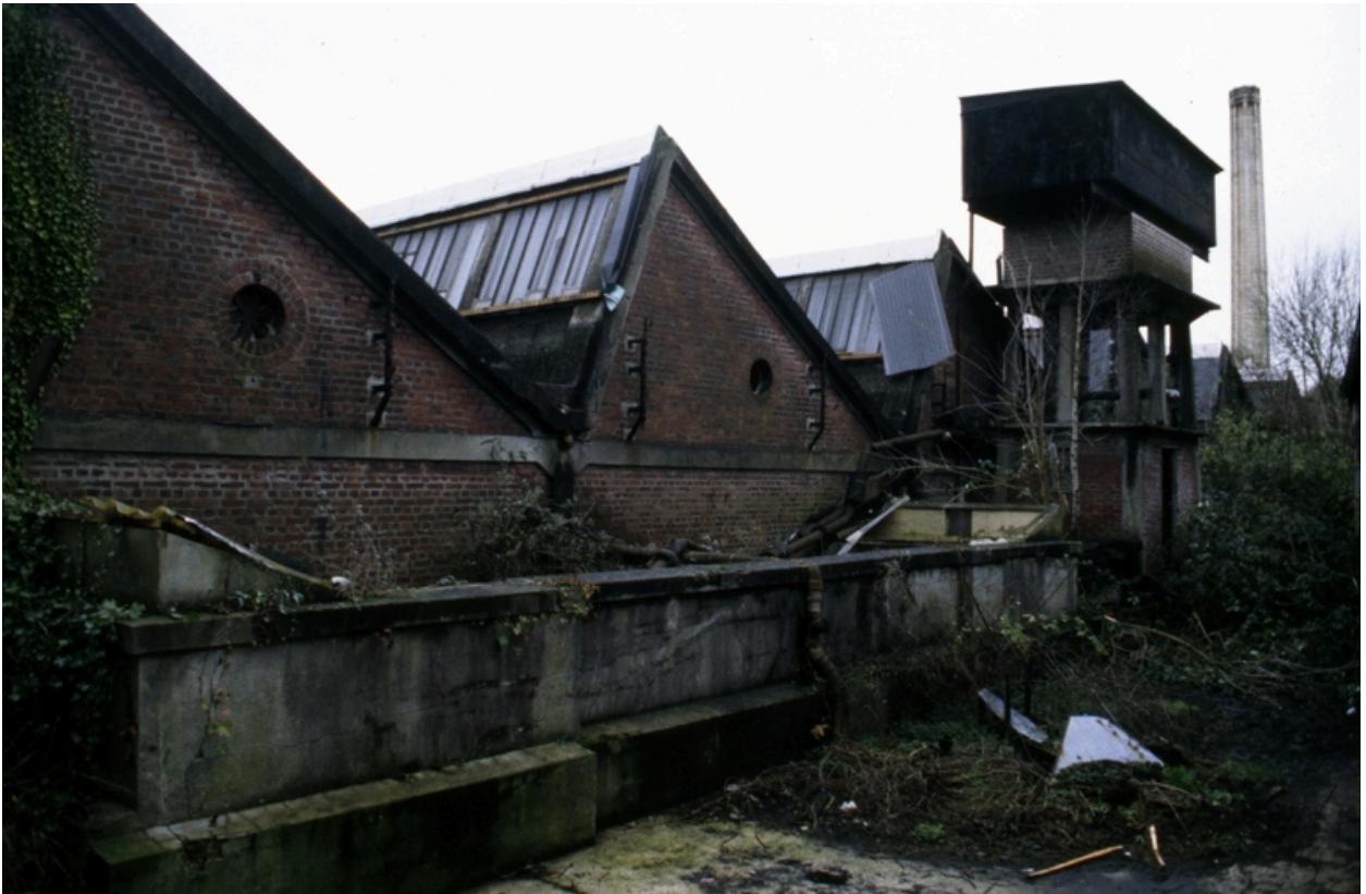
Réservoir de la chaufferie et son bassin réfrigérant, 2001.
