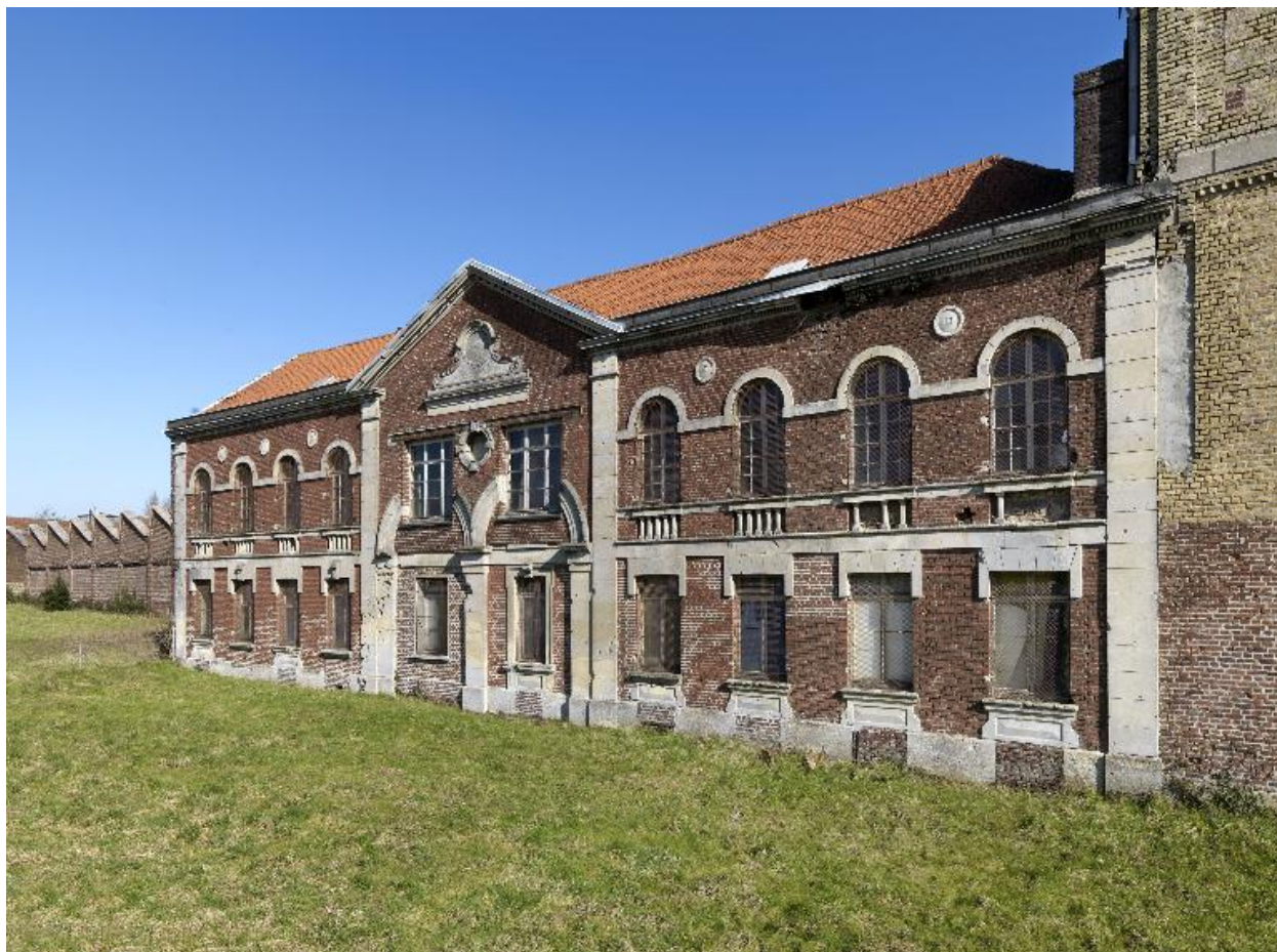
Façade ouest de l'atelier de pliage.
