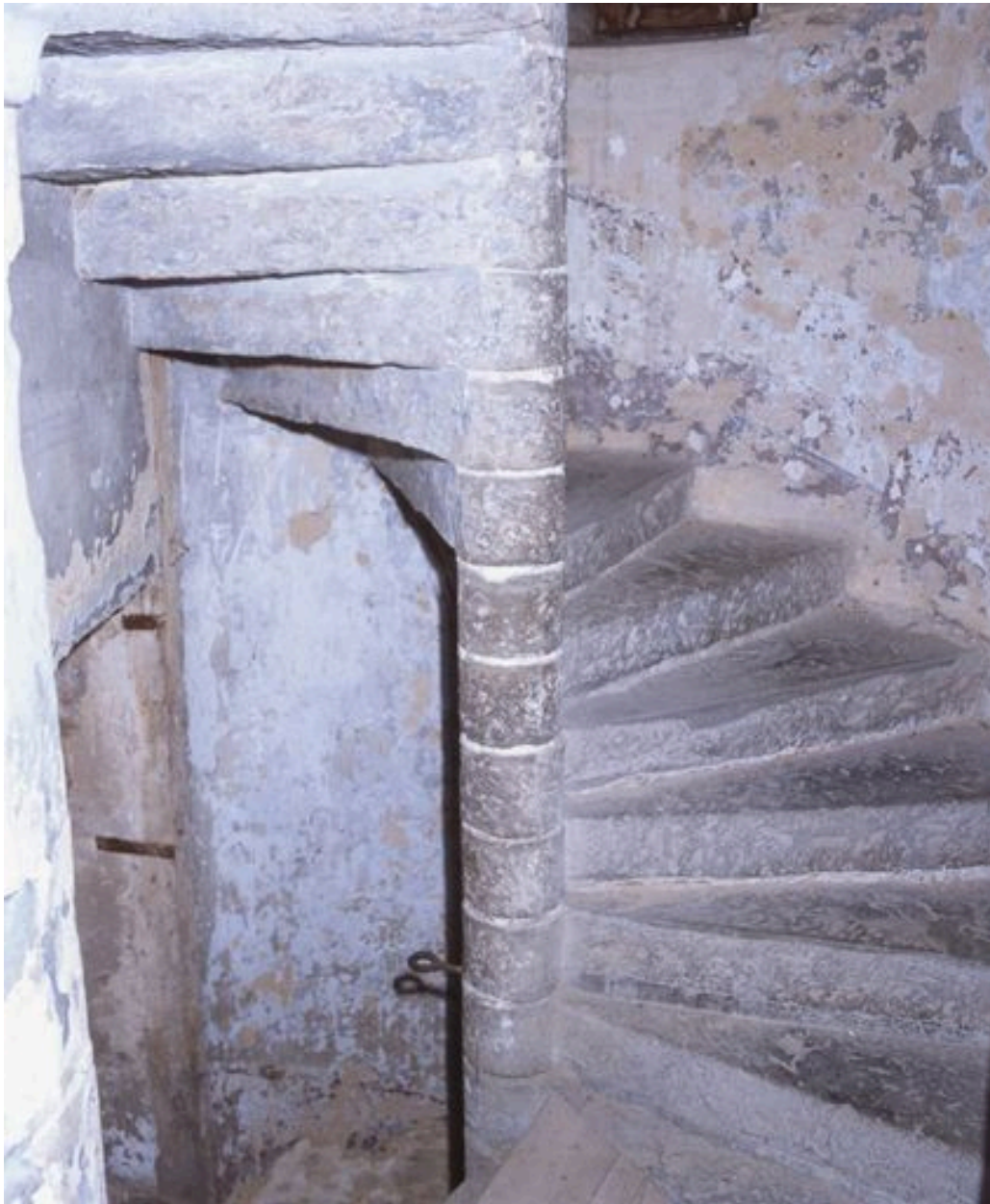
Corps de logis médiéval, intérieur, tourelle d'escalier (ouest), montée entre le 1er et le 2e étage, vue partielle.
