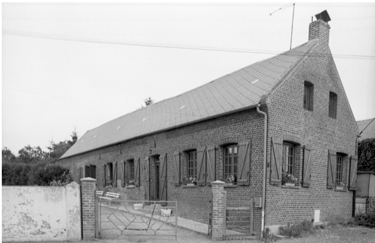
Vue d'ensemble sud-est.
