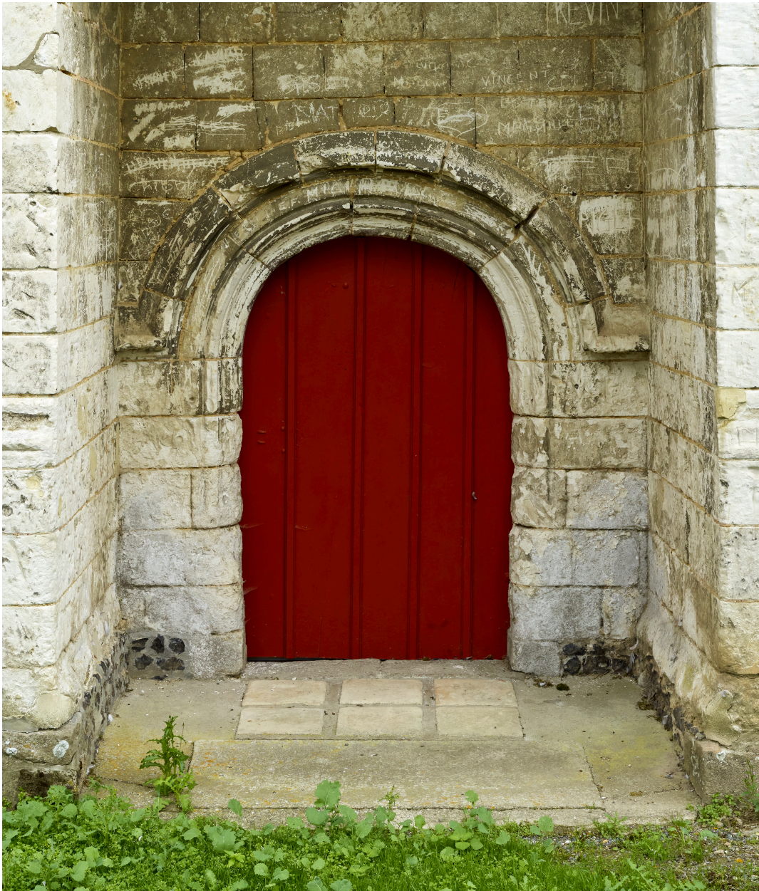
Détail du portail occidental.
