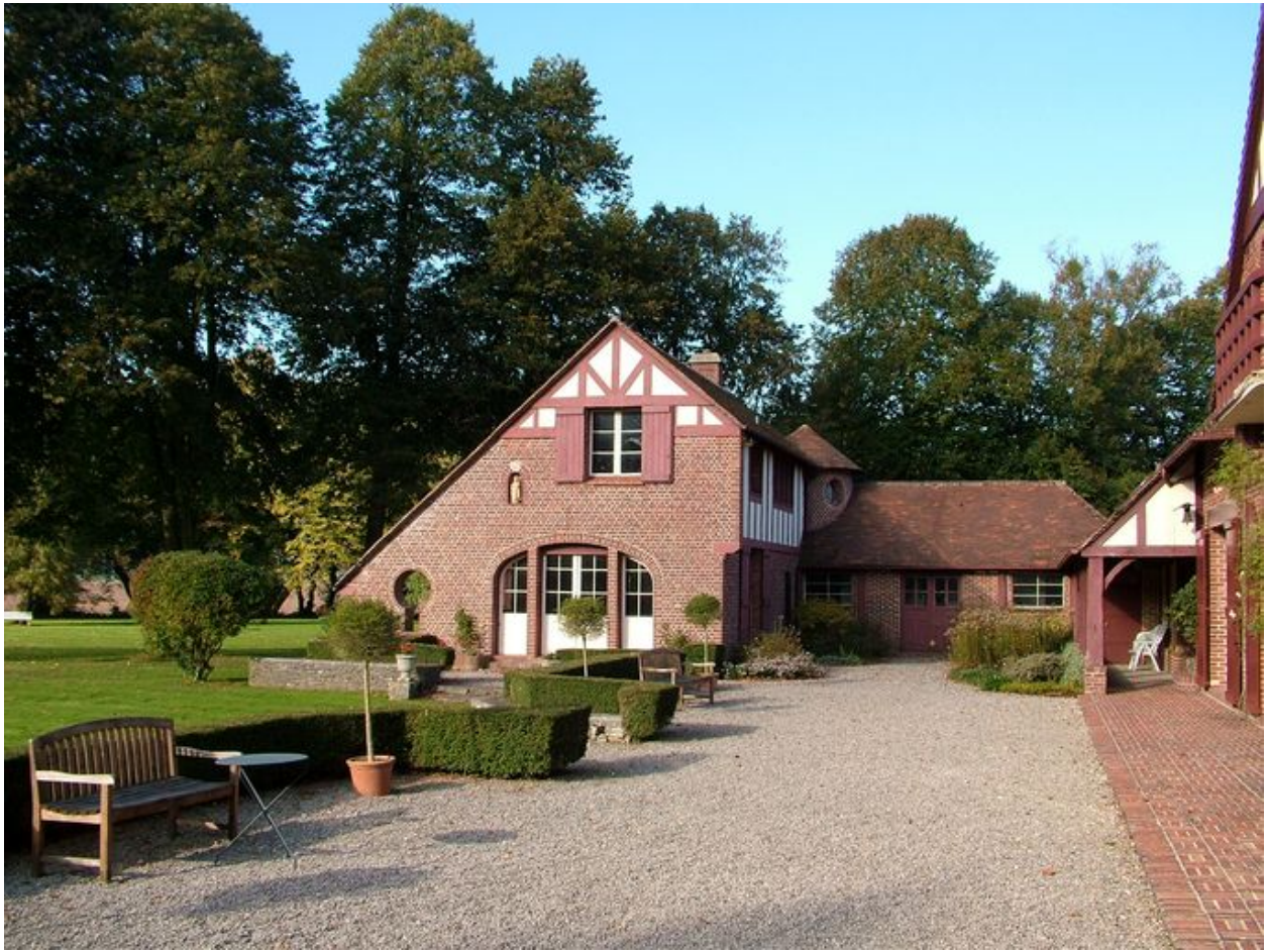
Bâtiment en retour d'équerre et pavillon postérieur.
