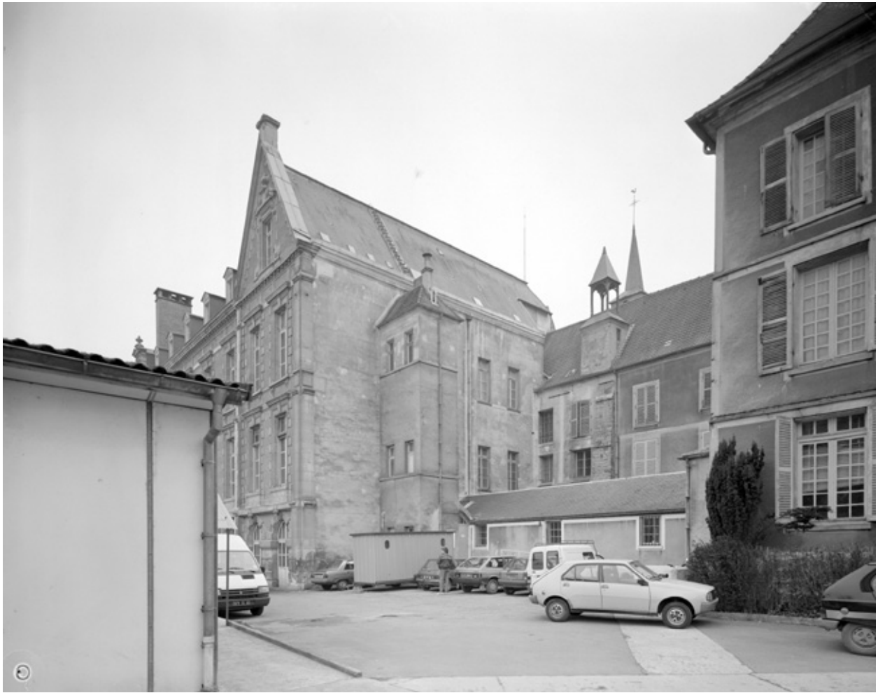
L'ancien bâtiment de la communauté des religieuses.
