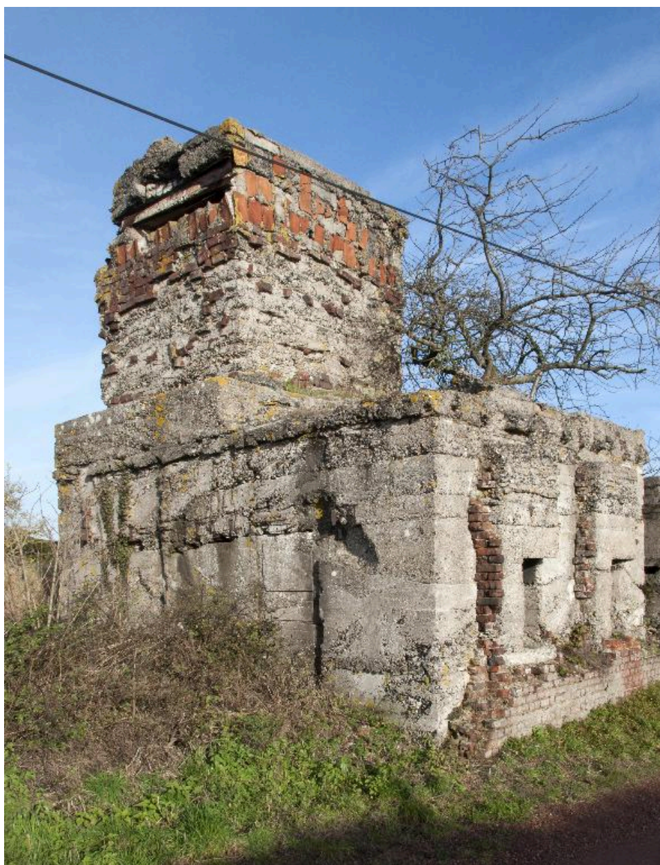
Tour d'observation casematé a, vers nord-est
