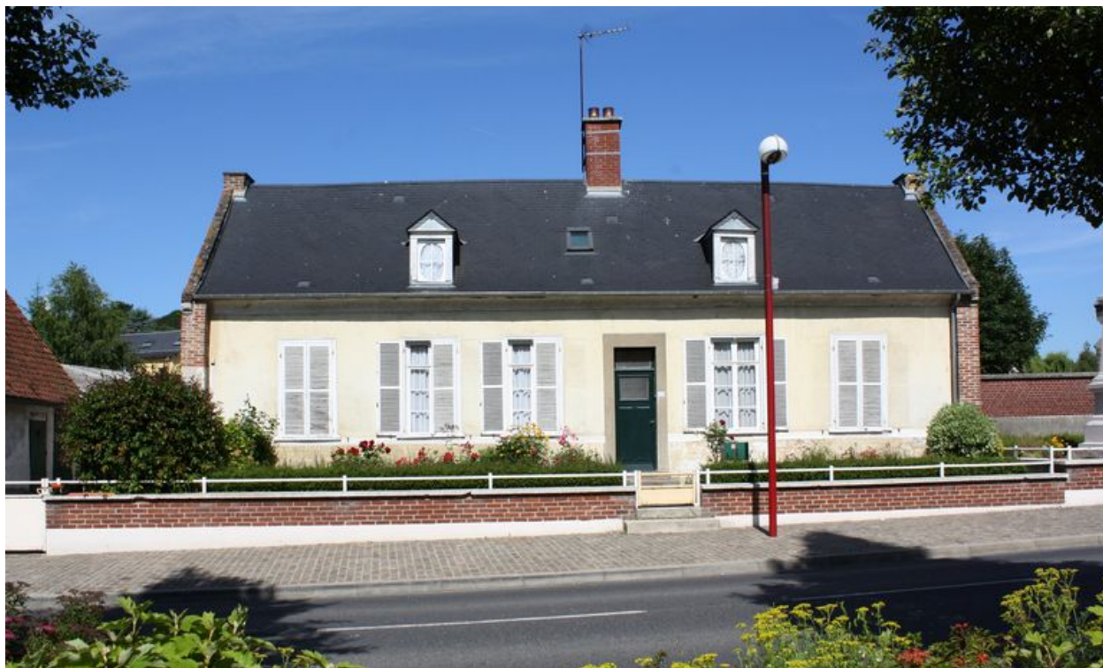
Vue générale, façade sur rue.
