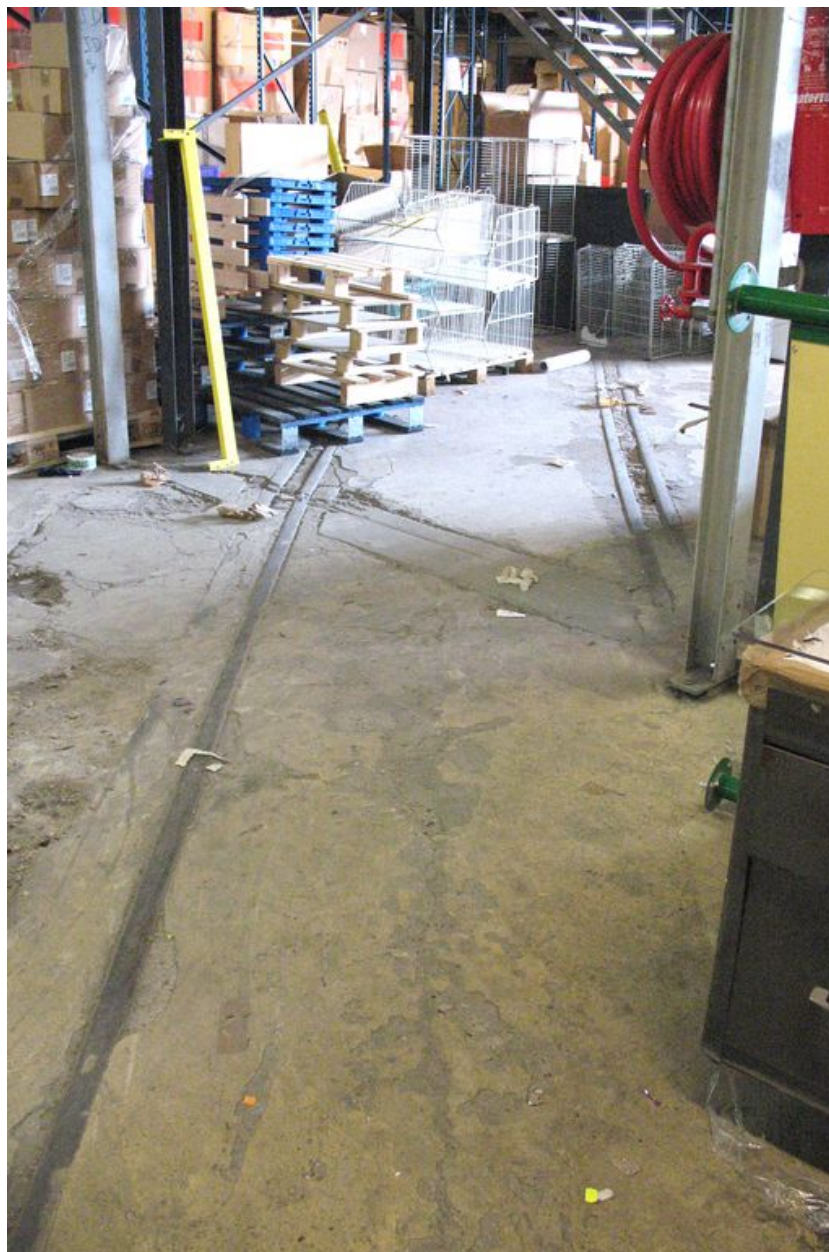
Vestiges des rails dans l'entrepôt.
