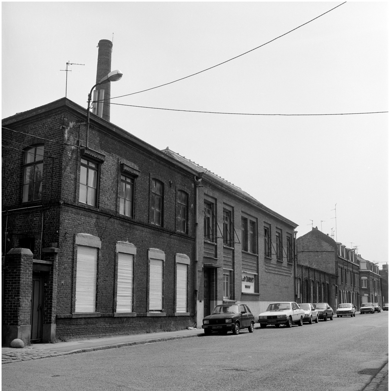
Élévation antérieure, rue des Fusillés.
