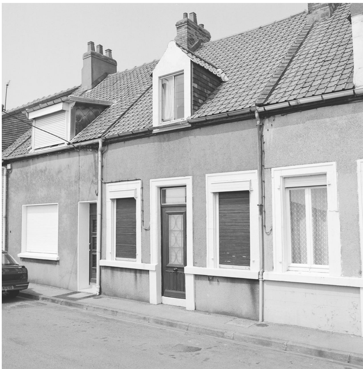
Façade sur voie.
