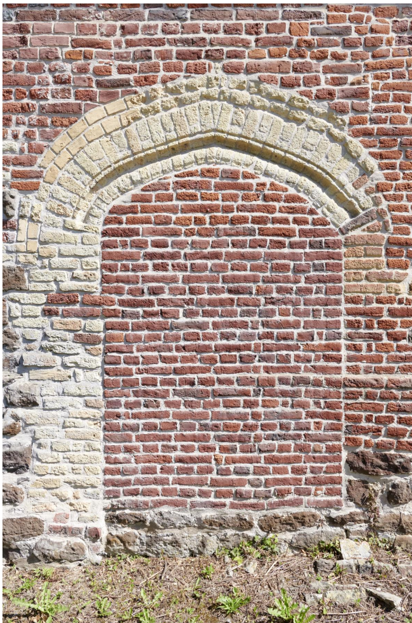
Ancienne entrée murée dans le bas-côté sud.
