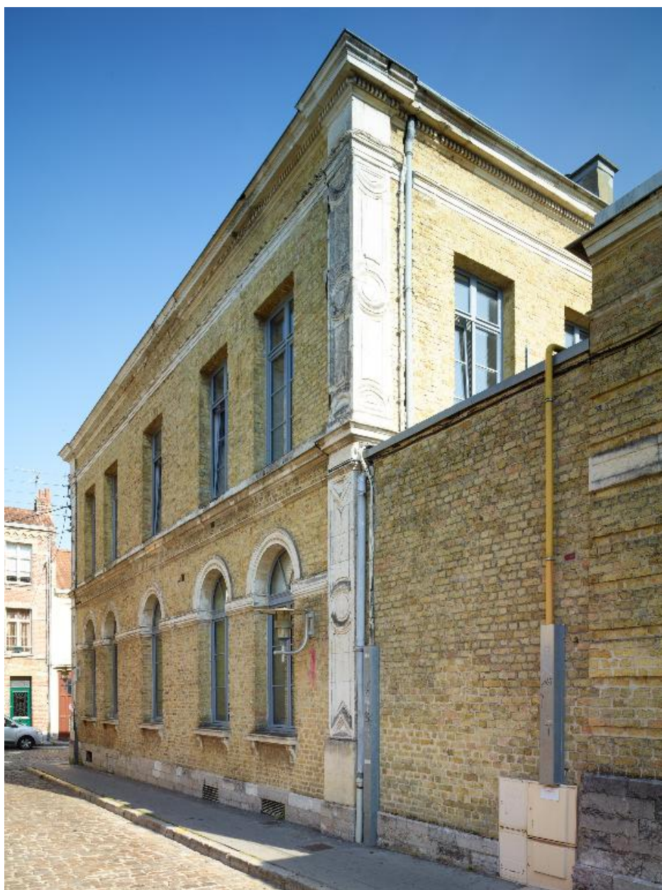
Vue depuis le sud.
