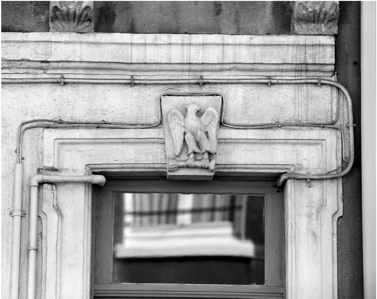
Linteau, rez-de-chaussée, clé n° 2, griffon.
