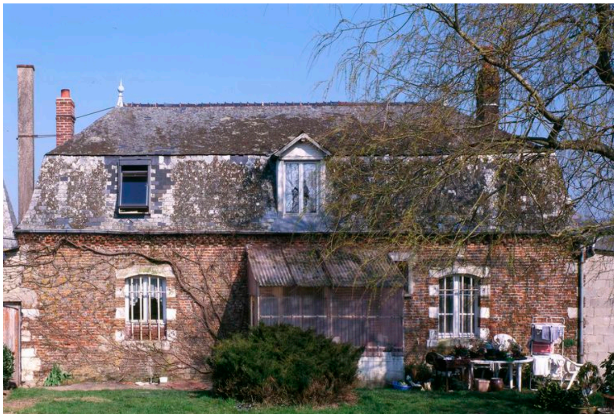
Elévation postérieure du logis.
