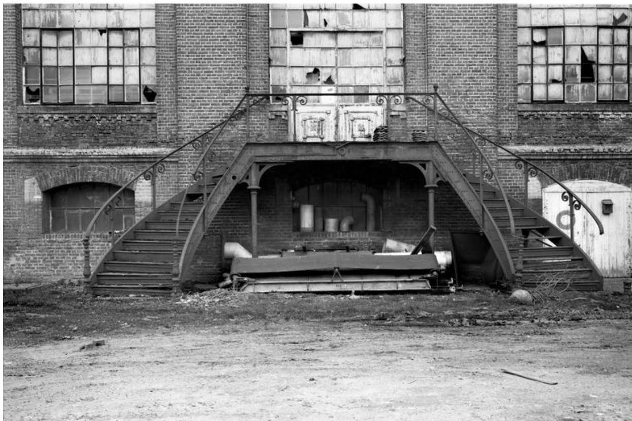
Escalier extérieur de la salle des machines, en 1988.
