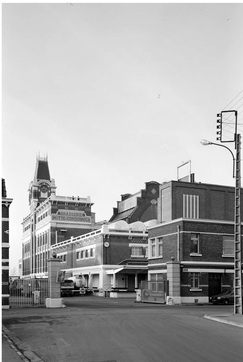
Vue générale depuis l'entrée.
