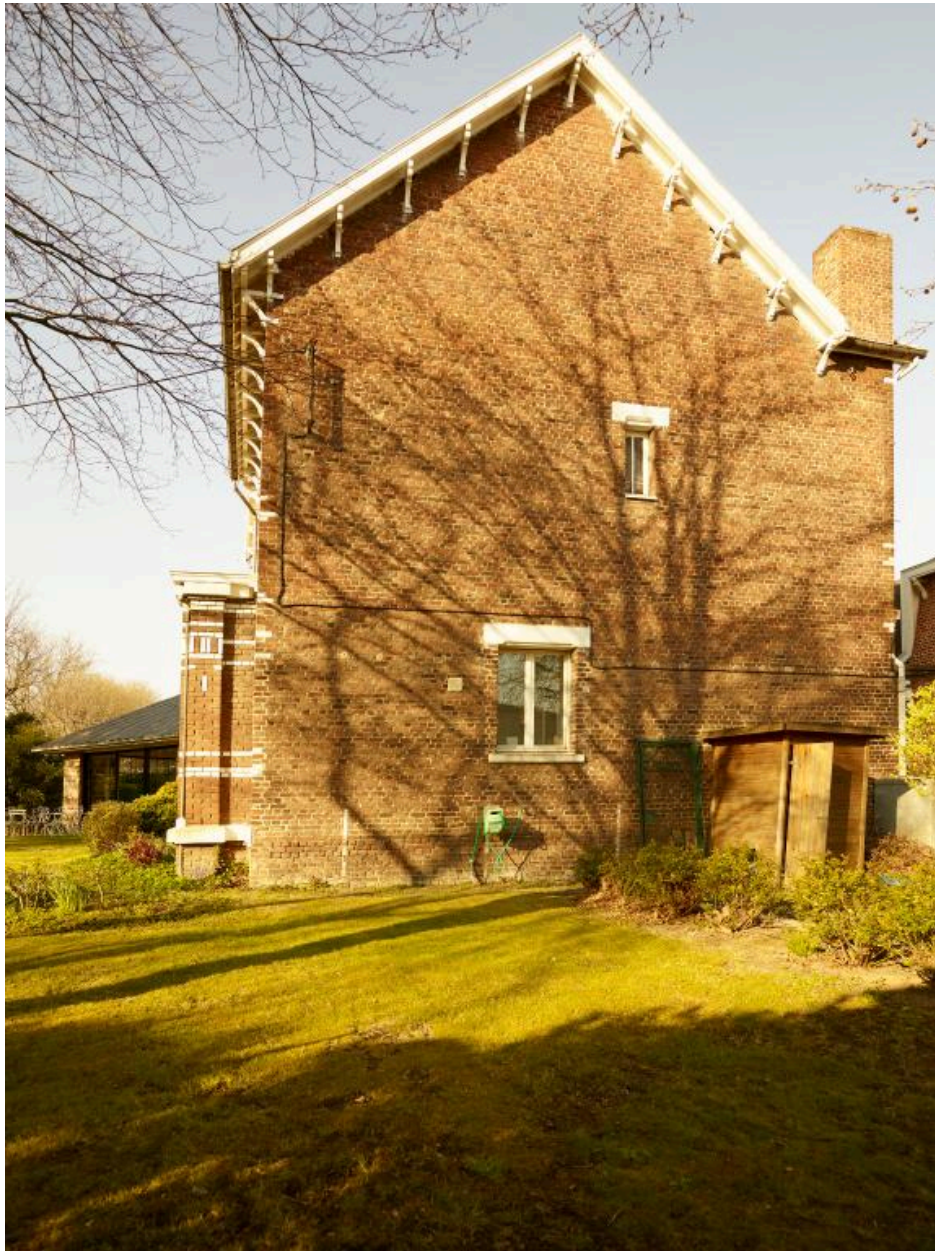
Logement patronal, pignon ouest.
