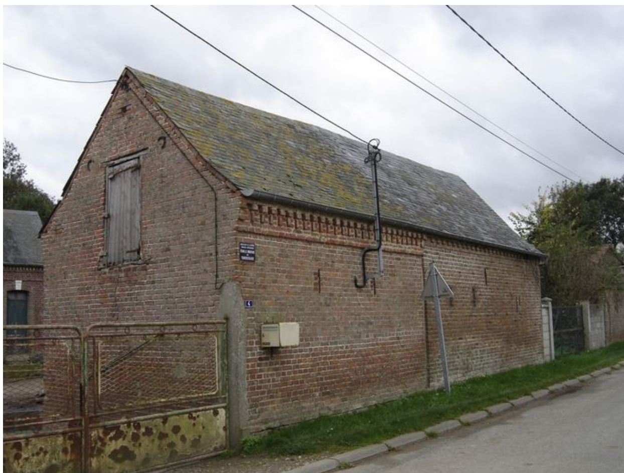
Vue des étables à cochons sur rue.
