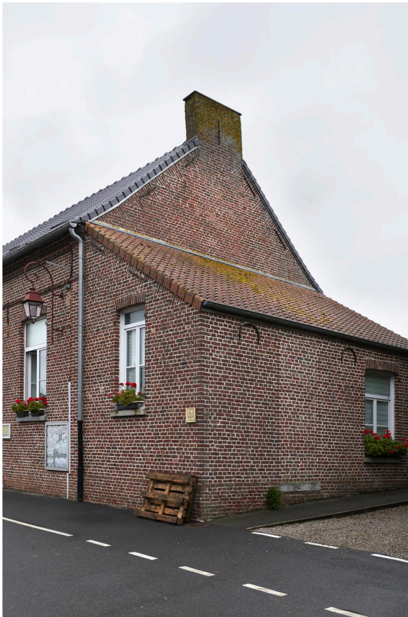
Détail de l'extension à l'est de l'édifice.
