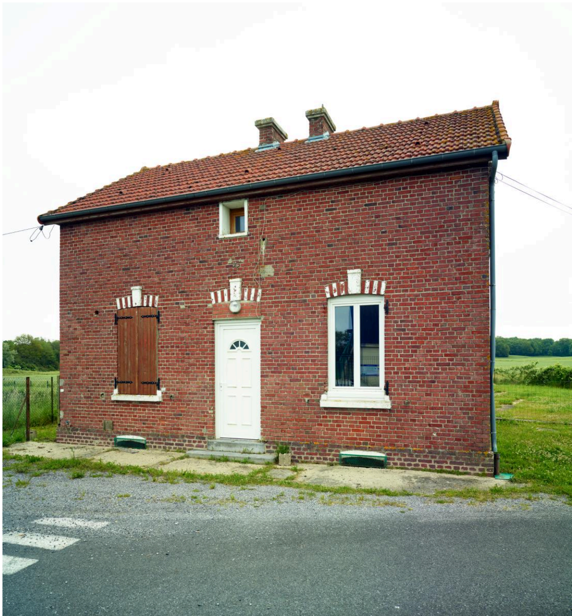
La maison de service (amont).
