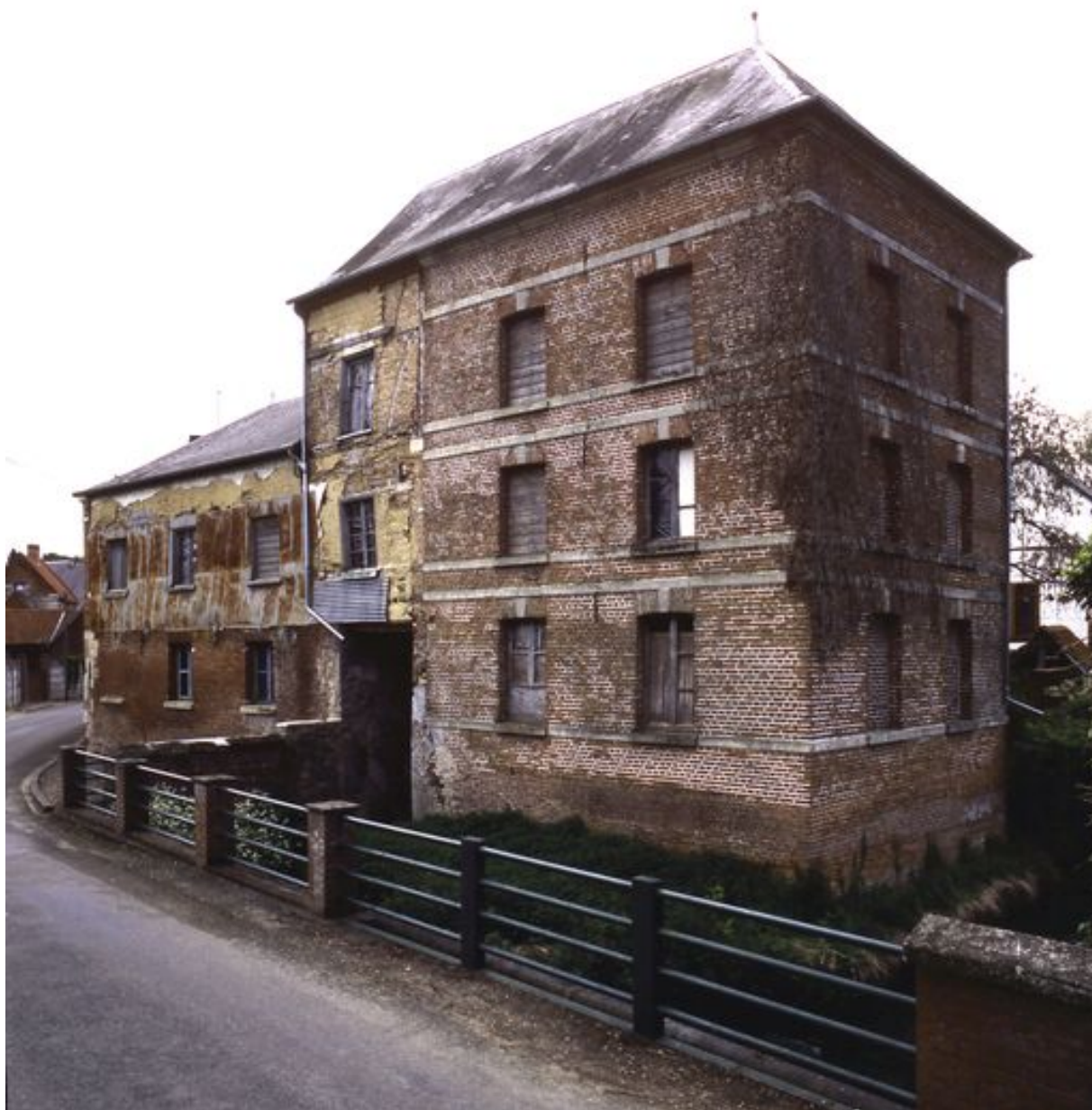
Vue d'ensemble sur rue du moulin.
