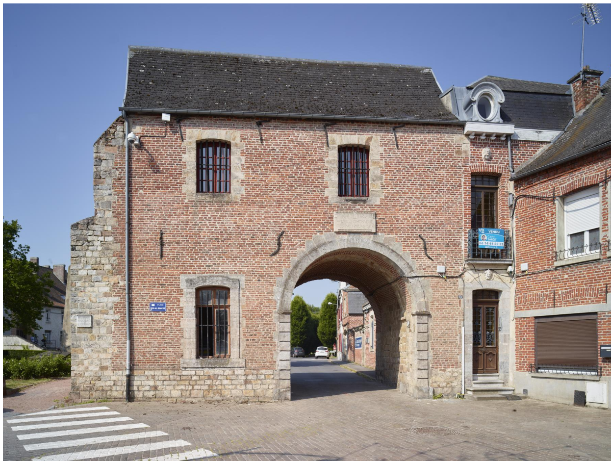
Porte de l'enceinte médiévale qui entourait le château comtal et ouvrait sur la place du Markiet (actuelle place du Général-Leclerc). Vue de face de la façade côté place.
