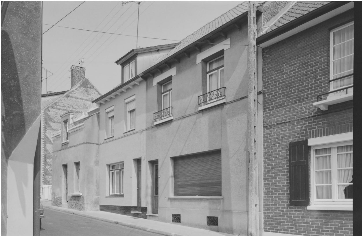
Vue générale de la maison du n°6 (au premier plan) depuis la rue.
