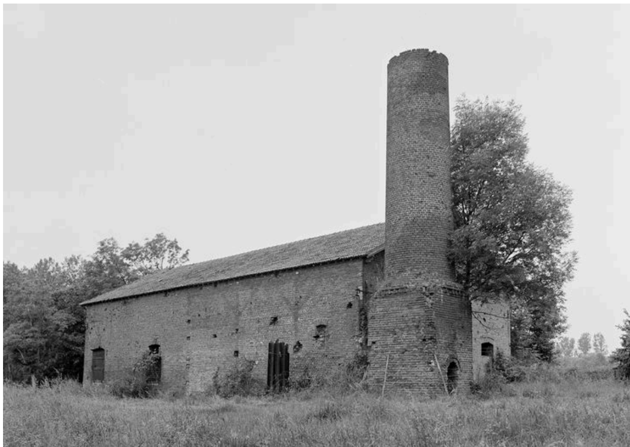
Atelier de fabrication, côté est et cheminée d'usine.
