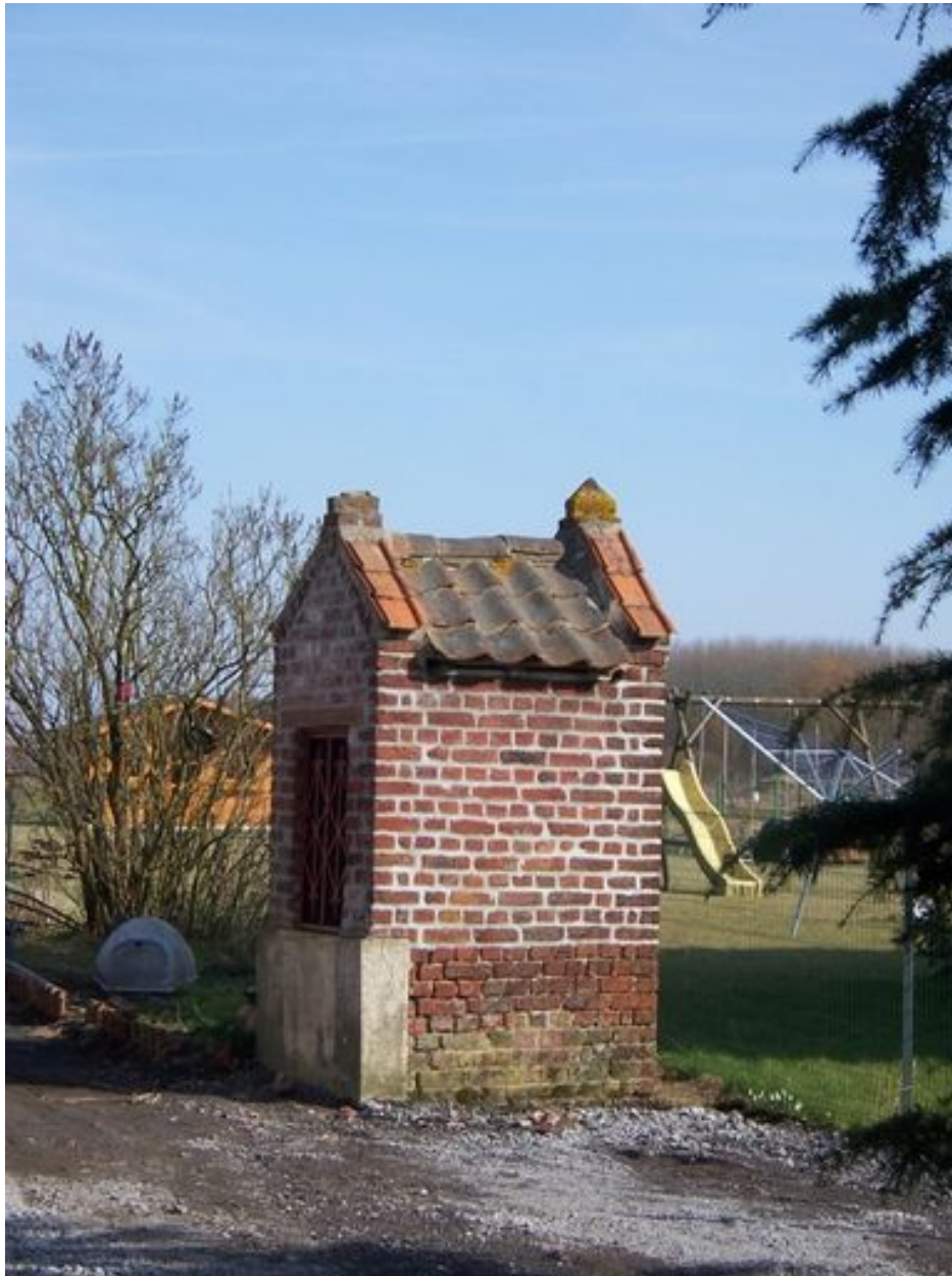
Vue générale du puits H.
