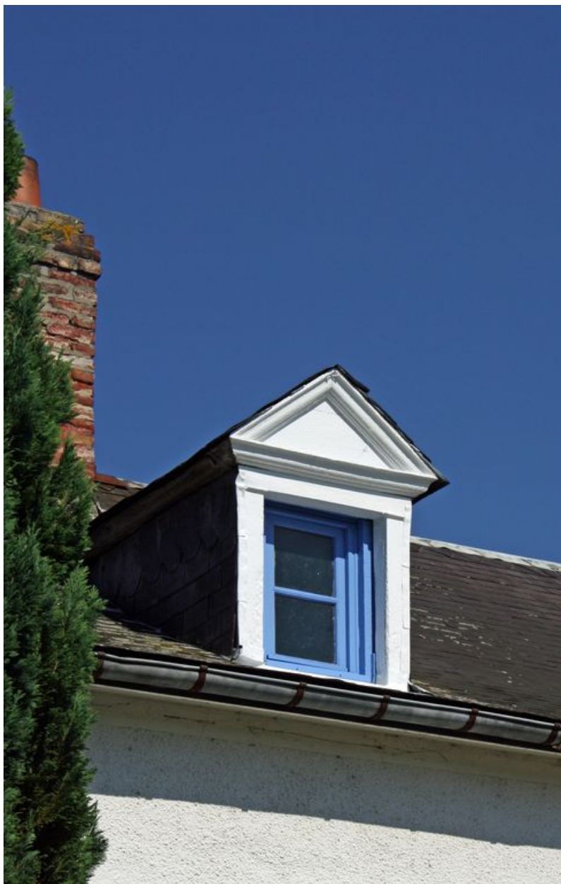
Détail de la lucarne en bâtière.
