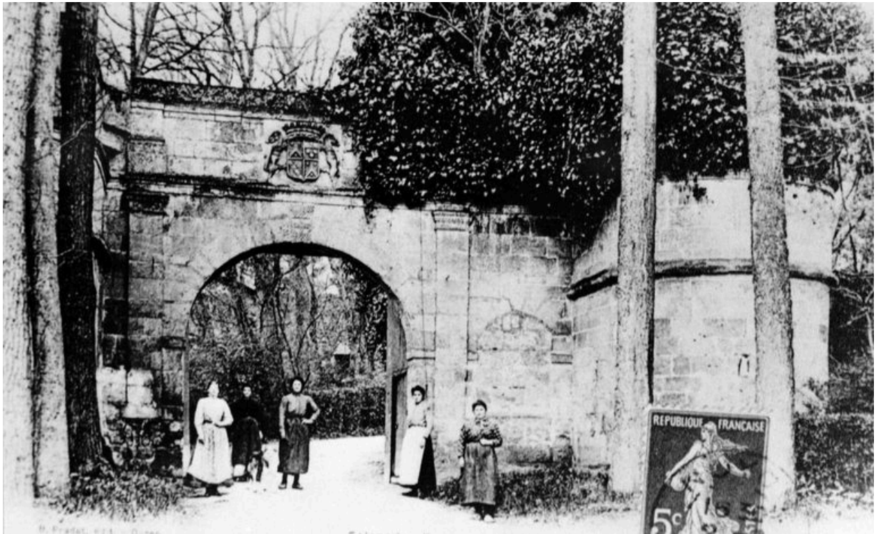
Détail de l'ouvrage d'entrée, avant 1914 (AP).
